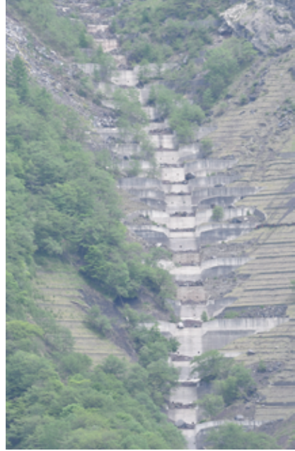
「大雑の崩れを防ぐ治山施設」 栃木県 宇都宮市 根本久
