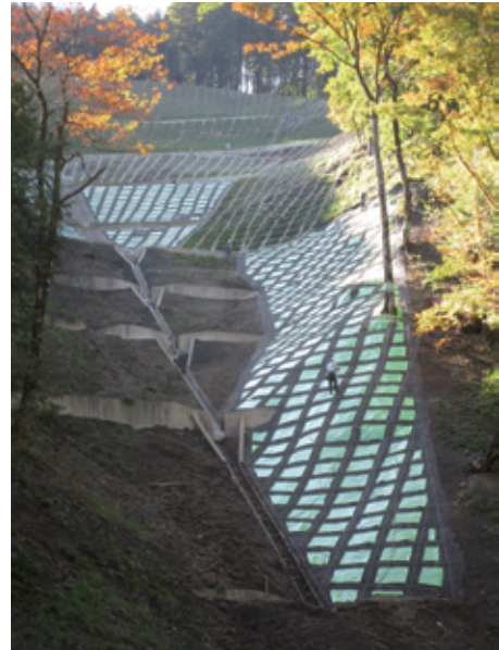
「きれいに仕上がりました」 群馬県 甘楽町 中島靖雄
