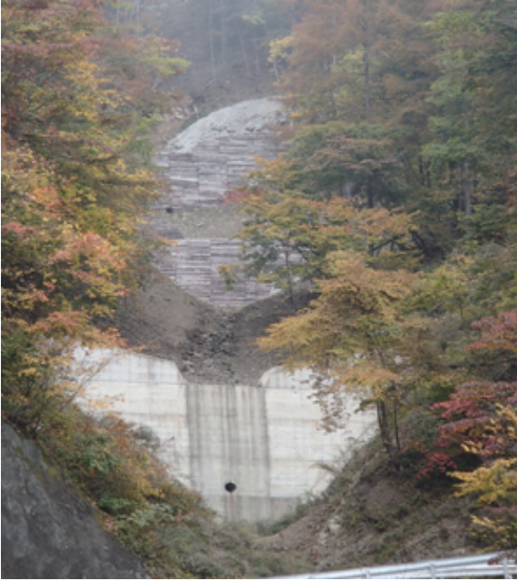
「これも治山ダム群」 山梨県 南アルプス市 上田正秀
