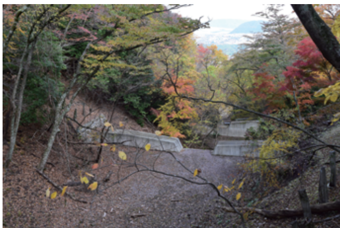
「土砂災害から暮らしを守る治山ダム」 大分県 大分市 一川洋
