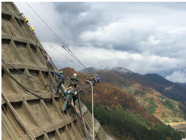
「施工状況確認中」
