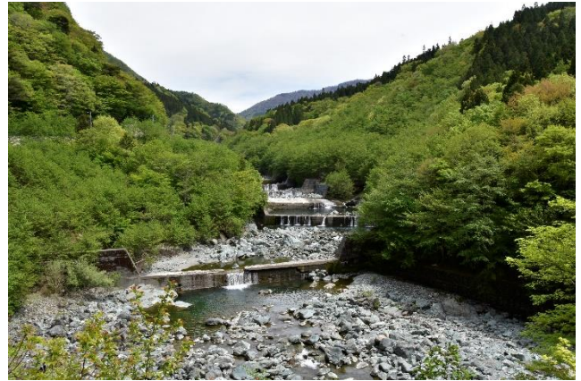
「治山ダム群」 徳島県 徳島市 丸田 泰史
