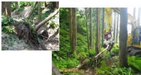
溪流における流木危険木の 事前伐採・除去 (R3～)
