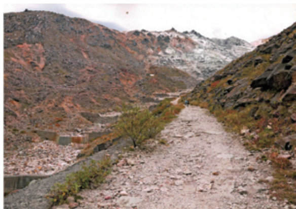
「三俣山の砂防えん堤」 長崎県 佐世保市 長谷川裕二
