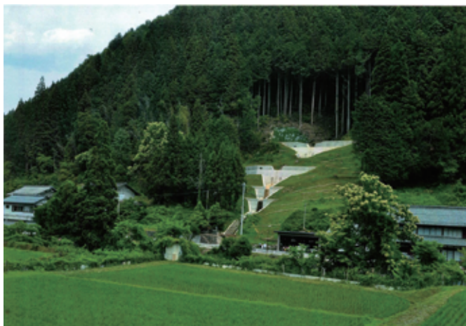
「山崩れなおったよ」 岐阜県 郡上市 高原 守
