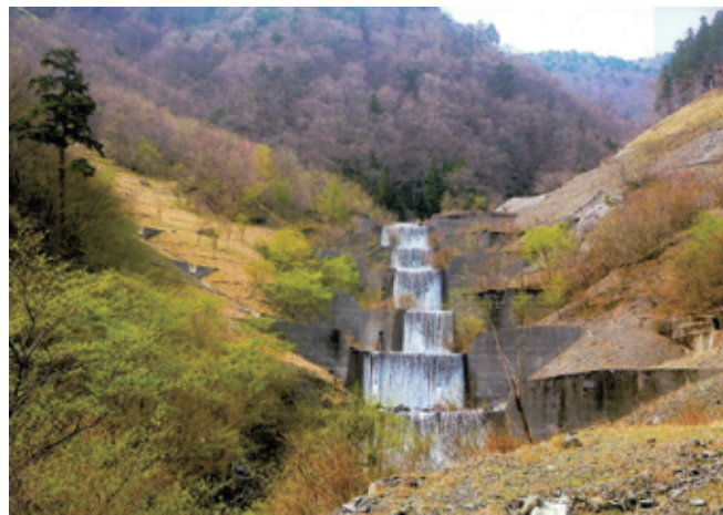
「溪間工(谷止群)」 徳島県 徳島市 古谷 綱崇
