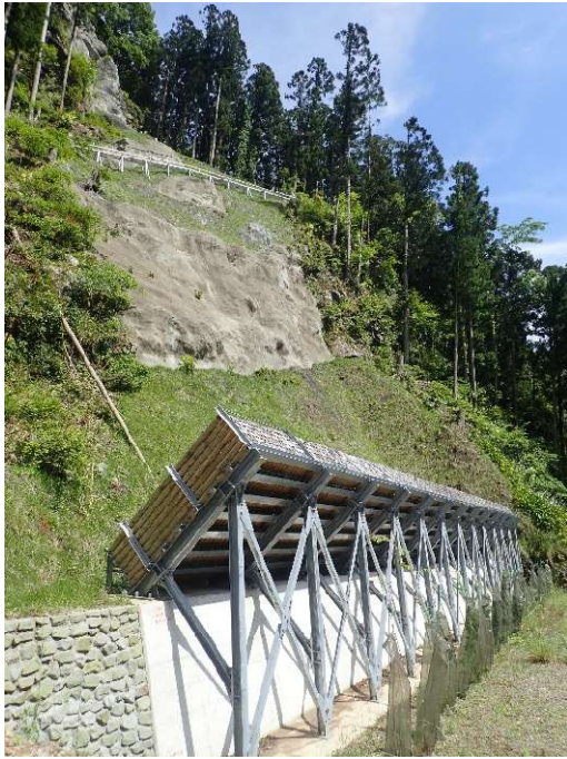
「治山（災害復旧）」 徳島県上勝町 関 康明
