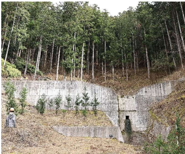
「堰堤建設と再造林」 愛知県清須市 増田興次
