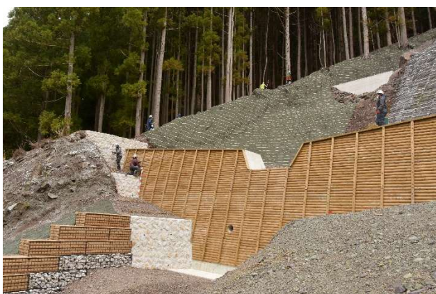
「木製残存型枠」 徳島県徳島市 丸田泰史
