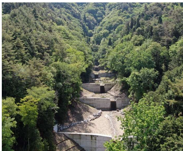
「谷止工完成」 岐阜県岐阜市 金子卓憲
